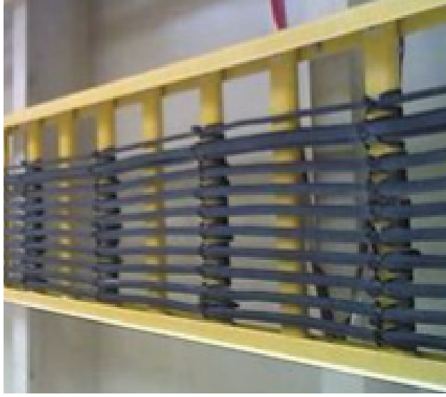
1/C CU 15kV in air
