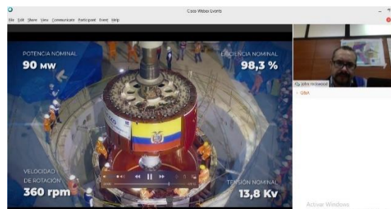
Imagen 8. Casa de máquinas de la Hidroeléctrica.
