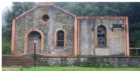
Imagen 2. Planta hidroeléctrica Chivilingo. Fuente: Hugh Rudnik. Permiso para su uso en NoticieEEro.
