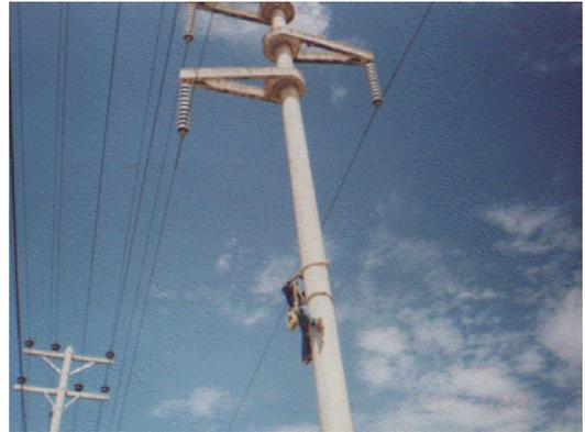
La técnica de lavado del aislamiento con la línea o subestación energizada, comúnmente llamada lavado "en caliente", es de gran uso a escala internacional y fue utilizado por primera vez en Australia, por el año 1932 en líneas de 33 kV donde el lavado natural no eliminaba el contaminante depositado en el aislamiento. Posteriormente, esta técnica fue aplicada en países como Alemania, Rusia, Japón, Suecia, Noruega, Polonia, Estados Unidos, etc.
