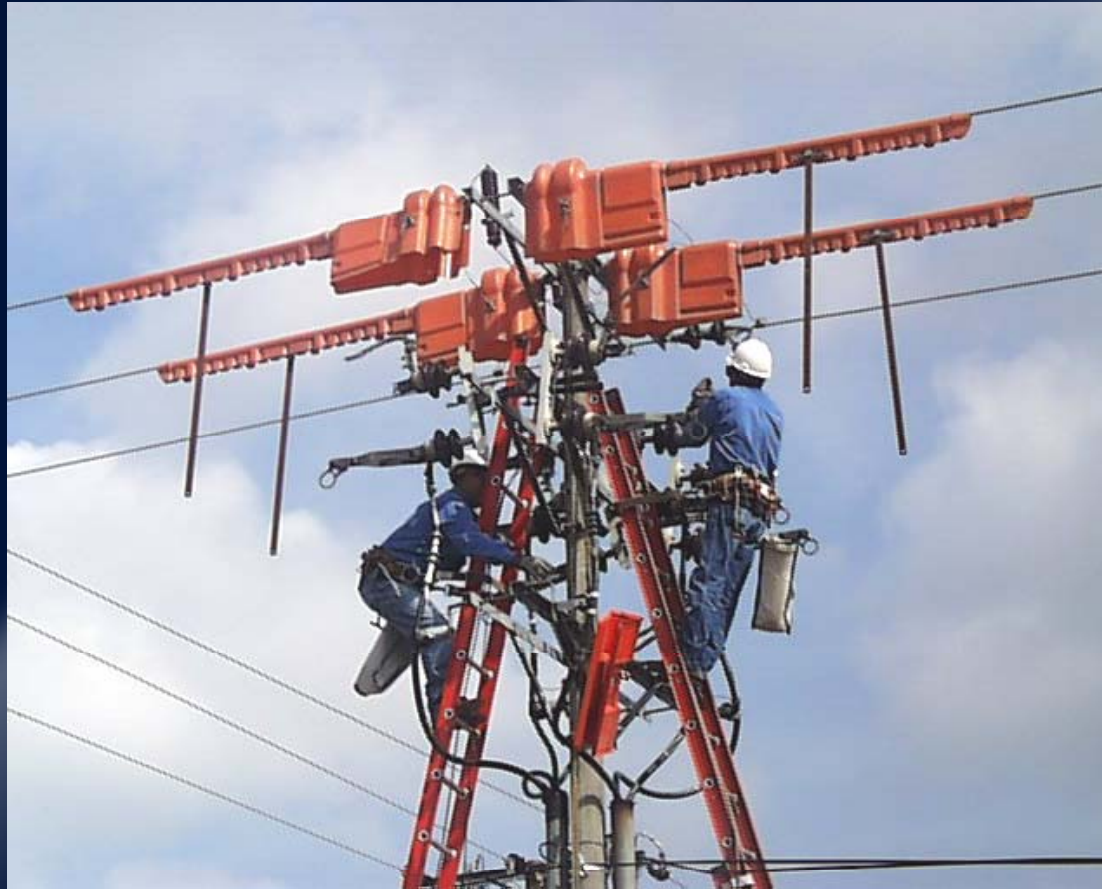
Trabajo en Línea Energizada
