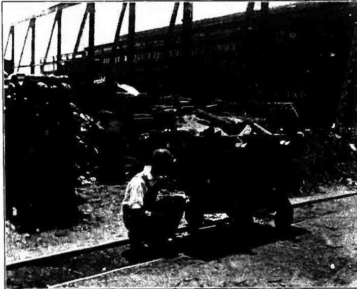
A. FOUNDRY WORK. WEIGHING UP THE CHARGE.
